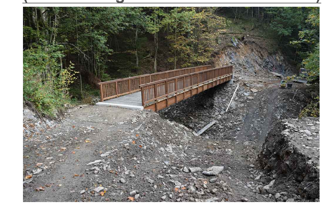
Beispiel für Naturstein"treppe" am Gewässer
